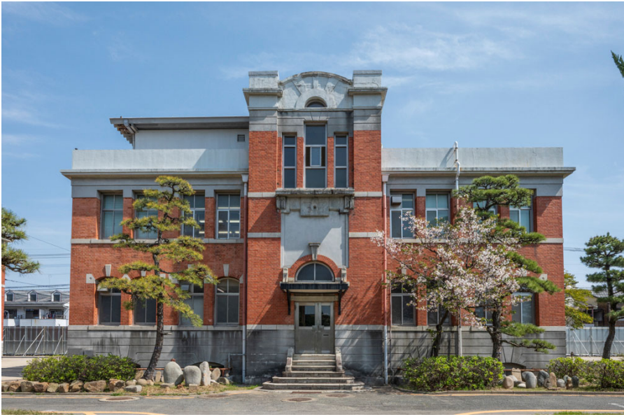
本部建築課棟 正面外観（西）
