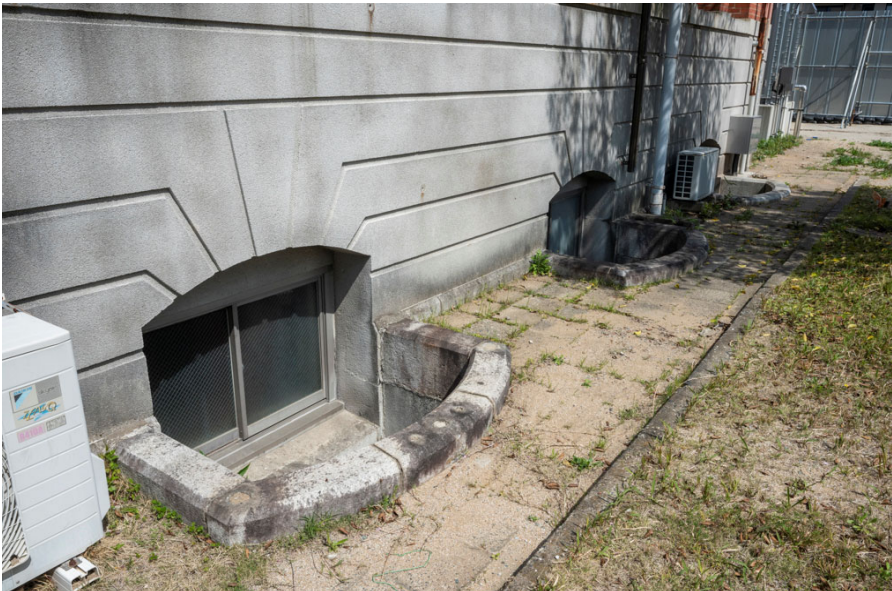
本部建築課棟半地下窓（南）
